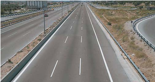
Σχ. 7.5α Αυτοκινητόδρομος.
